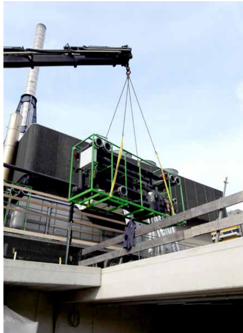
De WKO-installatie wordt naar binnen gehesen.
